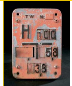
Hydrantenschilder weisen auf Wasserleitungsgröße und Lage der Hydranten hin.
